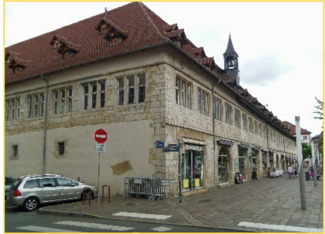
Les Halles, die Markthalle, deren Ursprung im 13. Jahrhundert liegt
